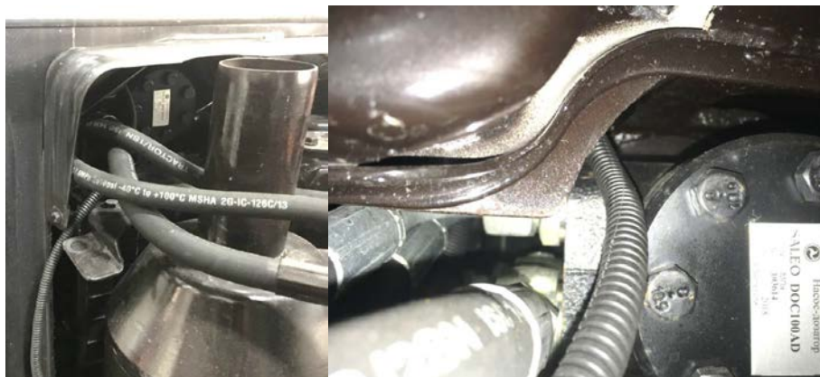
Рис. 4.3.23 – Протяжка жгута кабины в моторном щитке кабины
